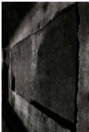
(2) 2トレンチ全景(東から)
