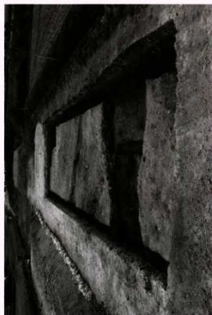
(1) 1トレンチ全景(西から)
