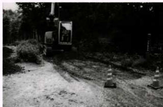
(1) 第1トレンチ重機掘削状況(北から)
