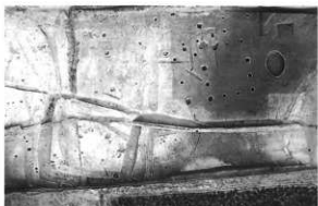
3. 2号溝跡付近全景 (南側より)
