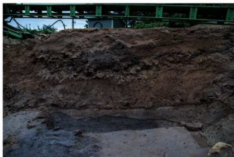
(3)第6次調査4トレンチ 東壁土層断面(西から)
