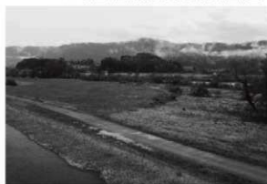
56 最上川上流荒砥地区外河道掘削工事(荒砥地区)(北東から)
