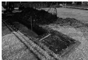
T1全景(南東から)
