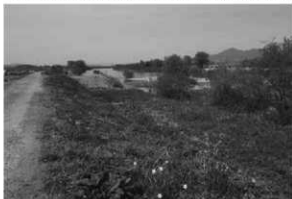
55 最上川上流満延地区管理用道路整備工事(南から)
