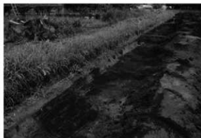
排水路工 南側遺構検出状況 (南から)
