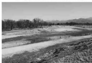
60 最上川上流村山地区河道整正等工事（西から）
