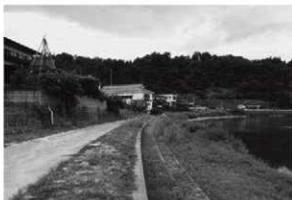
54 最上川上流大規模関連災害事業(左沢築堤)(南から)
