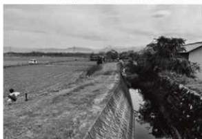
40 小鶴沢川河川整備事業（西から）
