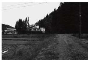
65 一般国道47号高屋防災事業(西から)
