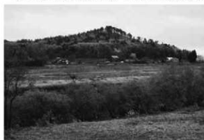
59 最上川上流梨郷地区河道掘削工事（西から）
