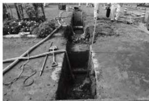
26 鶴ヶ岡城跡工事立会 (東から)
