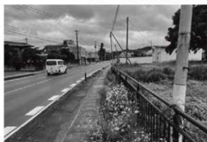
67 国道48号山形48号交通安全対策(山口歩道整備)(西から)
