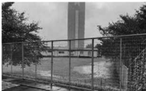
51 山形県立上山高等養護学校・山形盲学校 改築整備事業 (北から)
