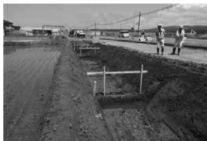
33 野瀬遺跡工事立会 (南から)
