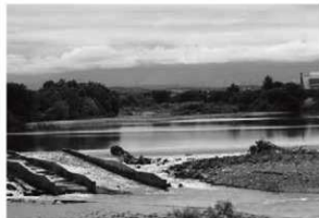
57 最上川上流荒砥地区外河道掘削工事(長井地区)(北から)
