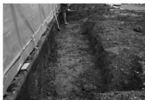
77 NHK 山形放送局雪上車庫建設工事 (南から)
