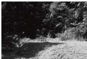
71 水上沢第2砂防堰堤 (寒河江川砂防) (北東から)
