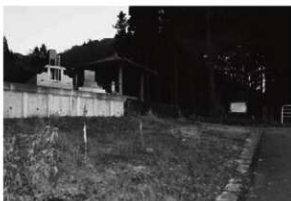
50 入沢地域防災力強化土砂災害対策事業 (北から)
