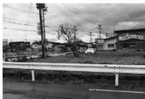
28 都市計画道路山元蔵増線 (西から)
