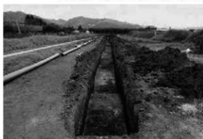
管用水路工全景 (南北) (南から)
