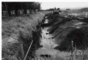
排水路工全景 (東西) (西から)
