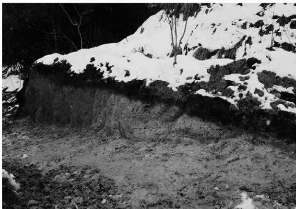
曲輪 A-A' 西壁土層断面 (北東から)
