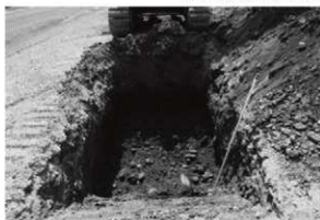
T 6 東側全景 (東から)
