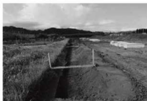
排水路工全景 (南北) (南から)
