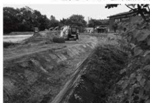
10 上野道跡工事立会(北から)
