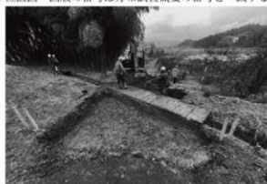
1 谷柏古墳群工事立会 (西から)
