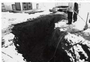
6 白金遺跡工事立会(南東から)
