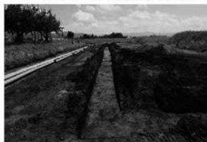
管用水路工全景 (東西) (西から)
