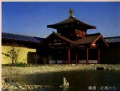
隅楼（北西から）
