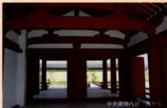
中央建物内部（西から）
