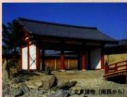
北東建物（南西から）
