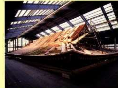
垂木をかけ、屋根をつくる
