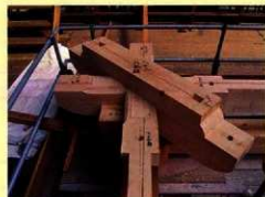
組物を組む （柱の上に梁材を据えあげていきます）
