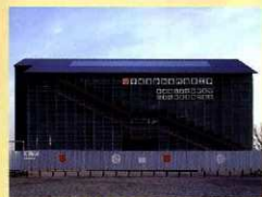
建設用覆屋（庫裏棟）の組立 （建設時の足場とともに雨風を防ぎます）
