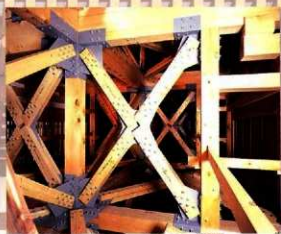
補強材の入った二重の内部
