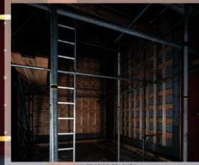
下层的墙壁内部
