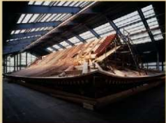
安装梯子，建造屋顶
