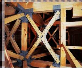
加入加固材料的上层内部
