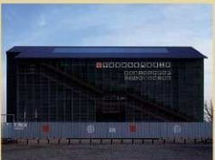
为施工而建的施工棚 (既可作为施工时的脚手架，又具有挡风防雨功能)
