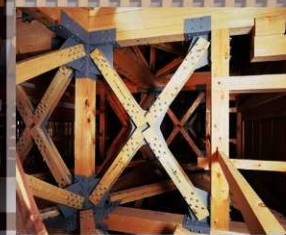
加入加固材料的上层内部
