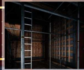
下层的墙壁内部
