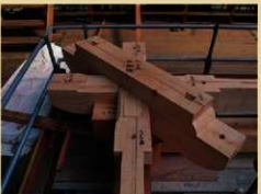
组装斗拱 (在柱子之上将各个建筑构件逐个组装起来)
