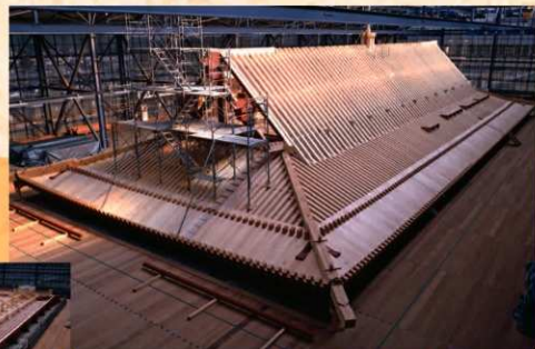
第一次大極殿復原整備 二重小屋垂木施工状況 ホイス点検台より (2006.10.30撮影)
