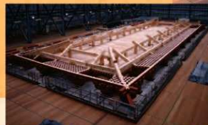
第一次大極殿復原整備 初重野地板施工状況 (2005.12.13撮影)
