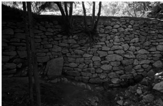
(1) 水ノ手口石塁 城外側（南東から）
