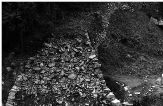
(1) 百間石垣 南端部 (6次 東から)
