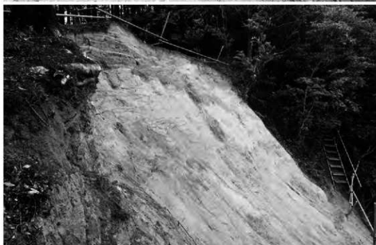
(2) 大石垣北方地区 C 区 土塁崩落部土層 (南西から)
