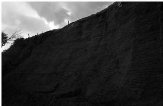
(1) 尾花地区 B 区 土塁崩落部土層 (東から)
