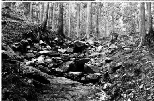
(3) 屯水地区C区 水門（北から）
