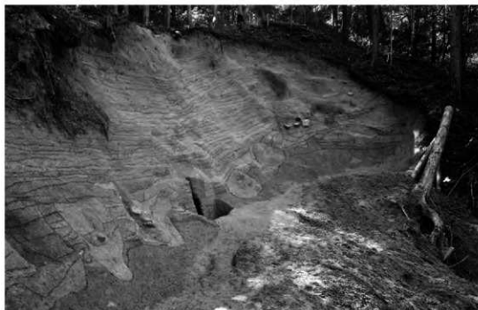
(1) 西側土塁 屯水地区F区 土塁崩落部土層（北から）
