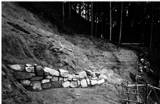
(2) 北石垣 A区(46次 北東から)
