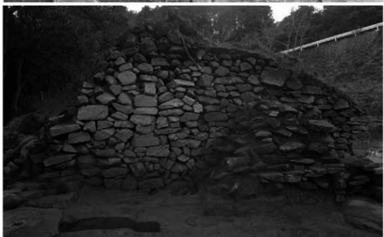
(2) 太宰府口城門Ⅰ・Ⅱ期 西側石積(Ⅲ期一部残る) (北東から)
