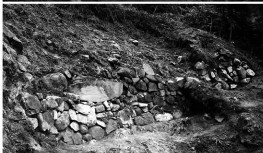
(2) 北石垣 東部石垣西側 (14次 北東から)
