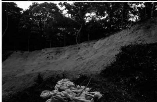
(2) 小石垣北方地区 A 区 土塁崩落部土層 (北から)
