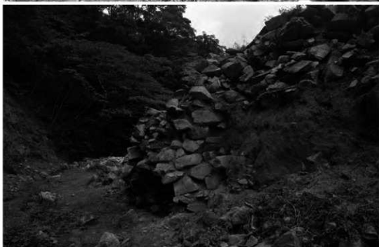
(2) 小石垣 A-7地点 石垣 (南から)
