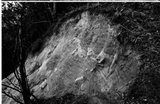
(3) 大石垣北方地区 E 区 土塁崩落部土層 (南東から)
