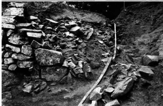
(3) 小石垣 B 区 石垣崩落部 (西から)
