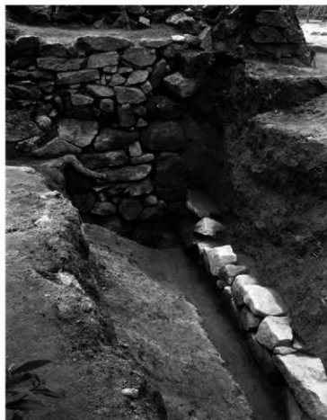
(3) 太宰府口城門 南側導入部石積 (南から)
