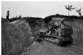
四王寺林道の拡幅工事
