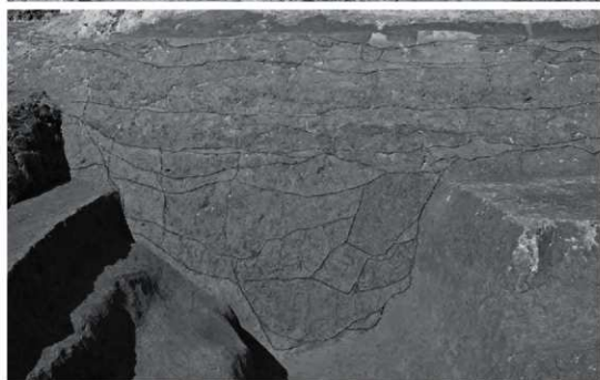
(2) 1号溝北壁土層 (南から)
