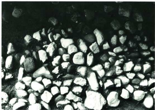
F-2 トレンチ
