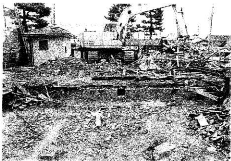
写真18-22 主体部北東角基礎
