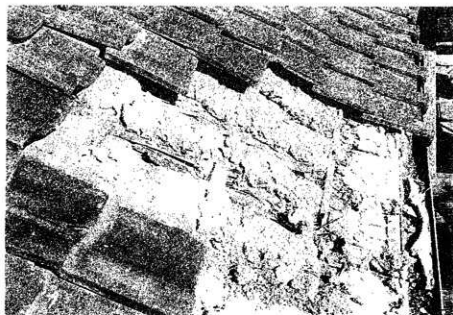
写真17-16 破瓦面の状況
