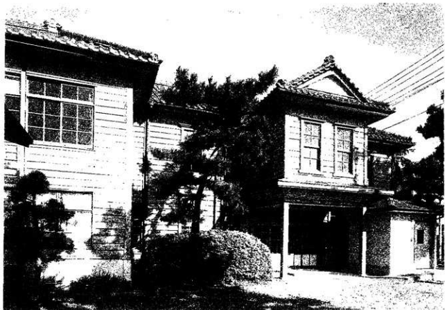
3 正面全景（南西より見る）
