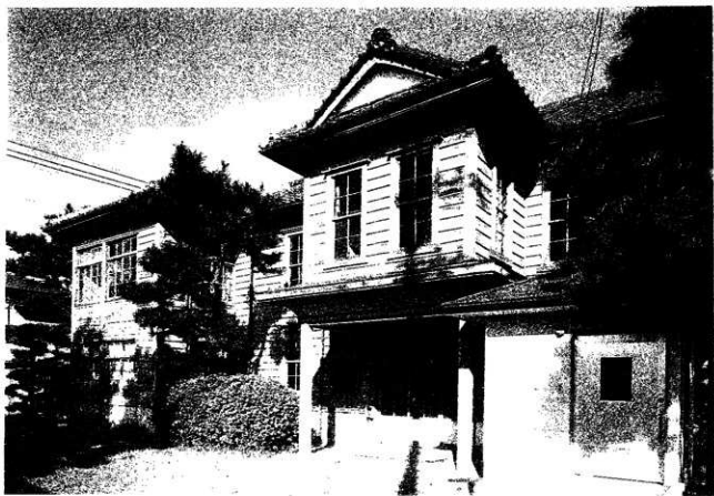
2 正面全景（南東より見る）
