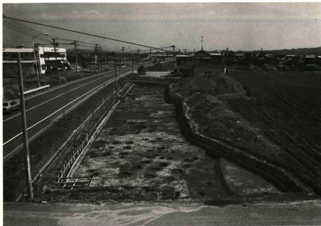
3 A ~ 3 D 区完掘全景 (国道南側・西から)
