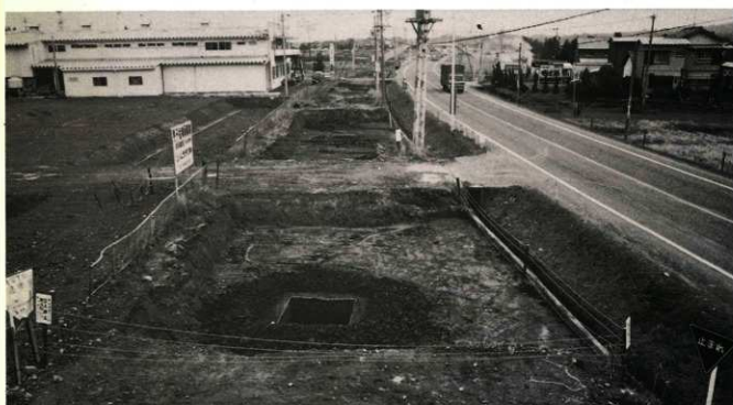
2A～2J区 試掘調査状況
