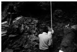
洞内 平面コンター図作成作業風景 (北より)
