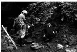
開口部 掘削作業 (北東より)
