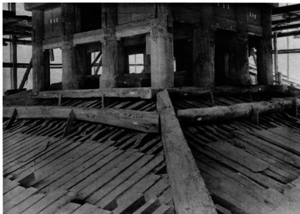
44 解体 二重化粧裏板
