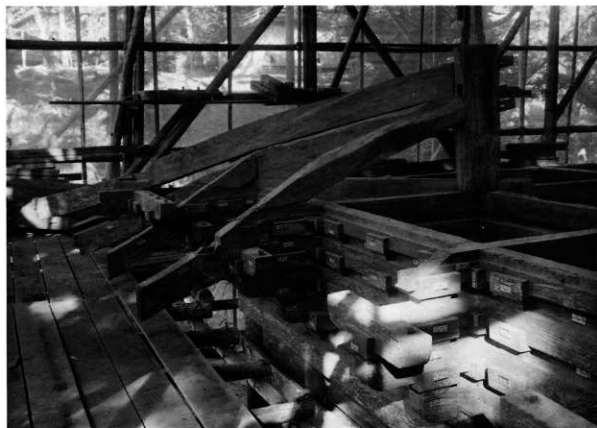
61 解体 初重尾樫 初重尾樫は柱真上にへの字形に木拵りにされ、尾樫尻は四天束に納差し、鼻栓打ちにしてあった。尾樫はすべて当初のもので松材である。
