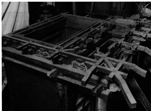
110 解体 斗拱、尾極の納り
