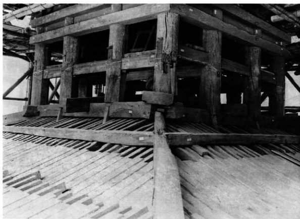
53 解体 二重軸部（其の2） 軸部、長押ともすべて当初のもので松材である。柱露出面の風化は大きく東面柱脚部の腐朽は甚だしかった。
