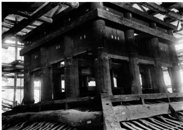
41 解体 三重軸部 軸部材、長押ともすべて当初のものである。柱の露出面の風化は大きく就中東面の風化は甚だしかった。現在腰貫の楔が漸行、梁行ともに下楔になっているが、大正修理時に打替えられたもので当初は梁行が上楔で、貫には3種咬合わせの仕口になっていた。
