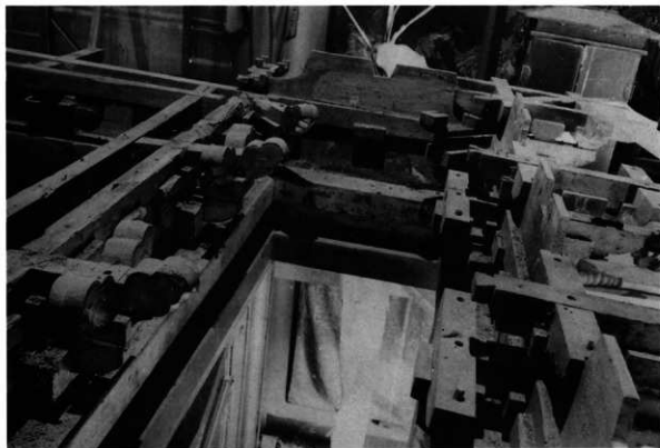
109 解体 斗拱、拳鼻の納り
