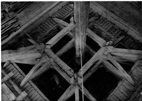
60 解体 初重隅木尻 初重の隅木尻は四天束納に差し鼻栓打ちになっている。
