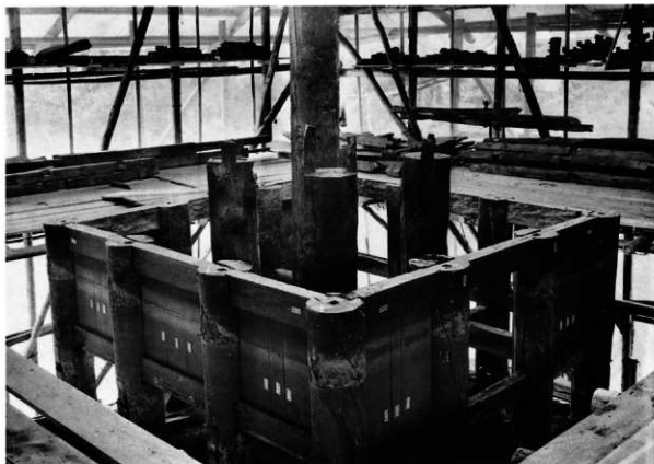
40 解体 三重頭貫 隅仕口はアリ掛、平は輪継込みにてほぼ良好な状態であった。
