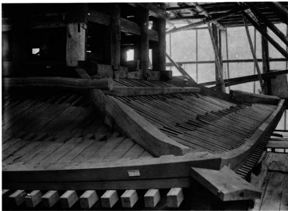
56 解体 一重軒廻
