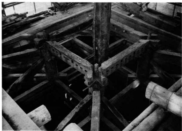
59 解体 一重種掛 各面とも中2本の種尻を突通し鼻栓打ちにしてあった。
