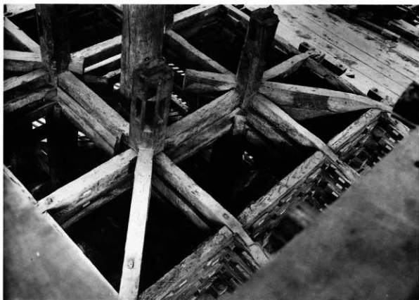
51 解体 二重通肘木
