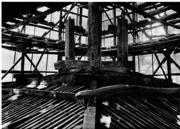
58 解体 一重土居桁及腰組束枕 土居桁は当初のもので、束枕は後補のもので、いずれも松材である。
