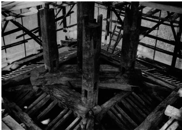
57 解体 心柱受梁
