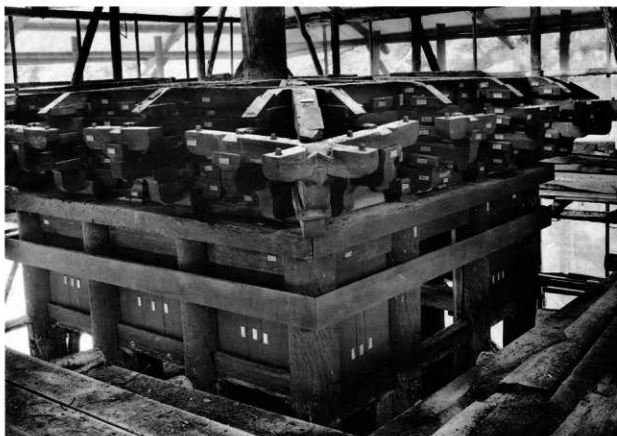
37 解体 三重通肘木 (其の2)
