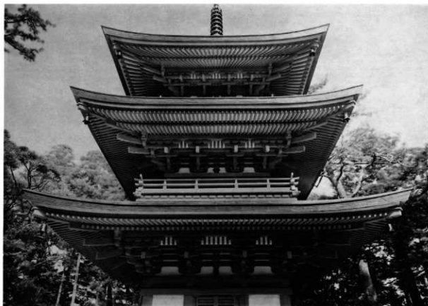
7 竣工 各重軒見上（西面）
