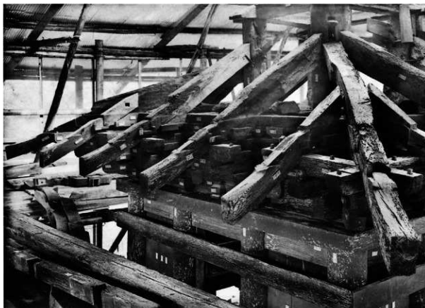
35 解体 三重 尾樑 尾樑は松材で雨漏りのため仕口部分の腐蝕が多かった。尾樑尻の束も当初のものである。
