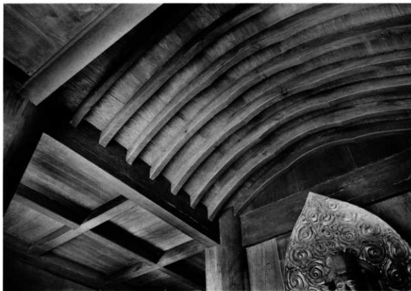
17 綾工 内部天井廻り
