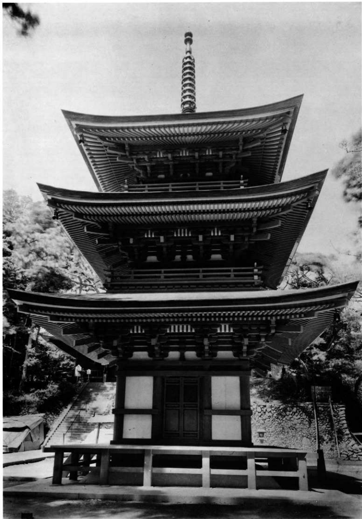
4 竣工全影南面
