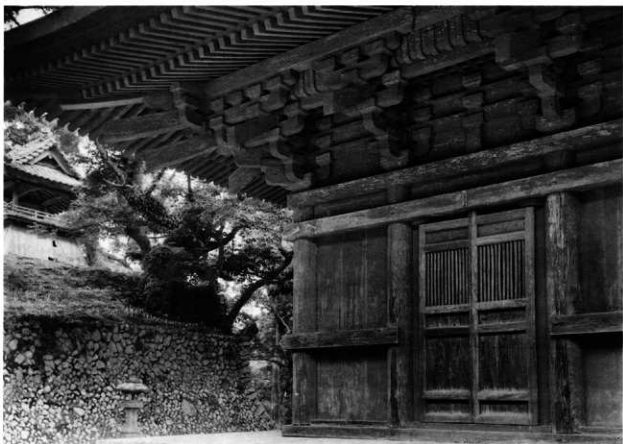
25 修理前 初重斗拱詳細
