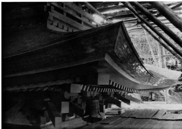
9 竣工 初重軒隅及二重の高欄
