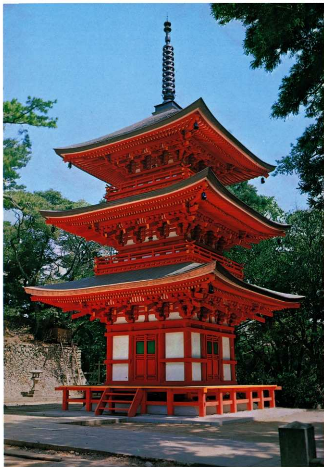
1 竣工 全影 西南面
