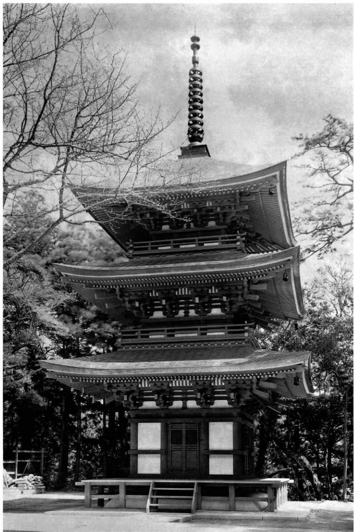
2 竣工 全影 正面 (西面)
