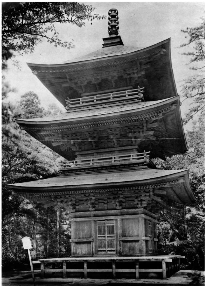
20 修理前 全影正面(西面)
