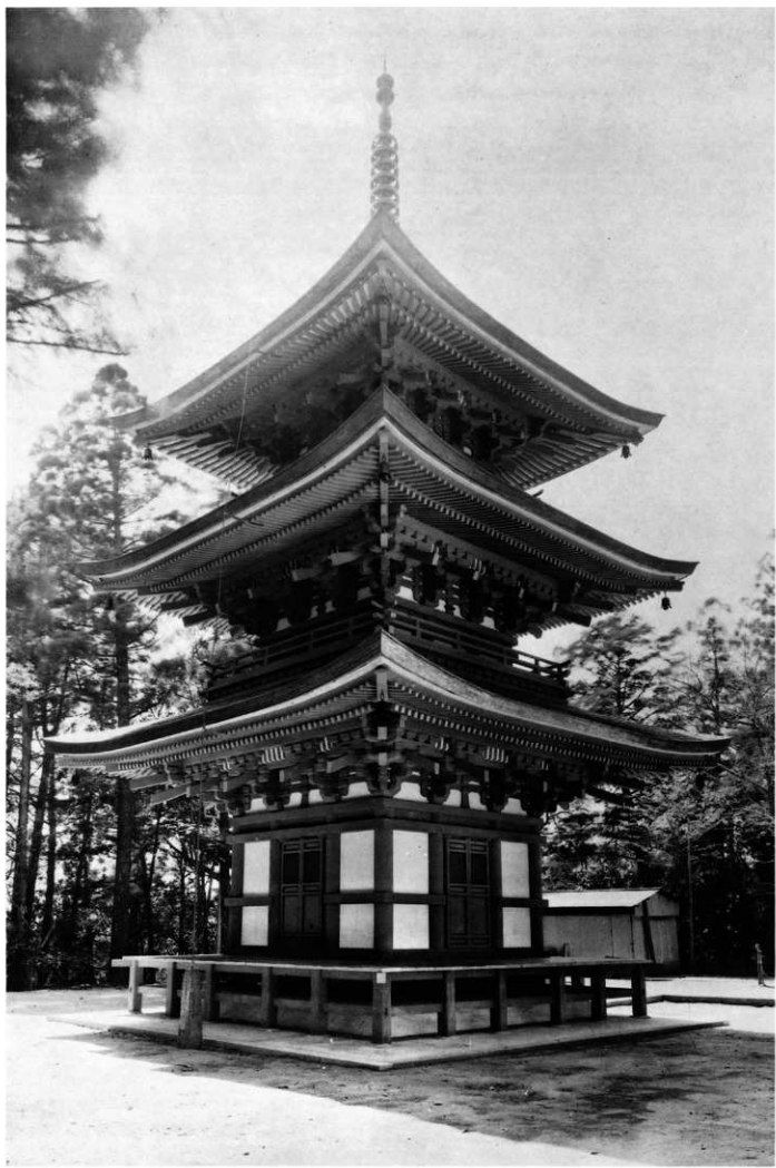
3 竣工 全影 東北面
