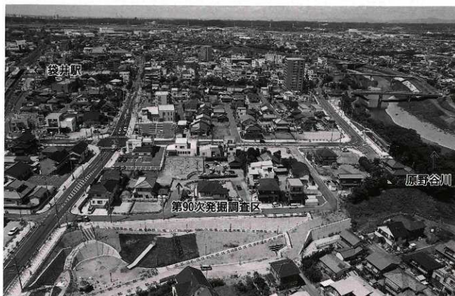
(1) 第90次発掘調査区空中写真遠景
