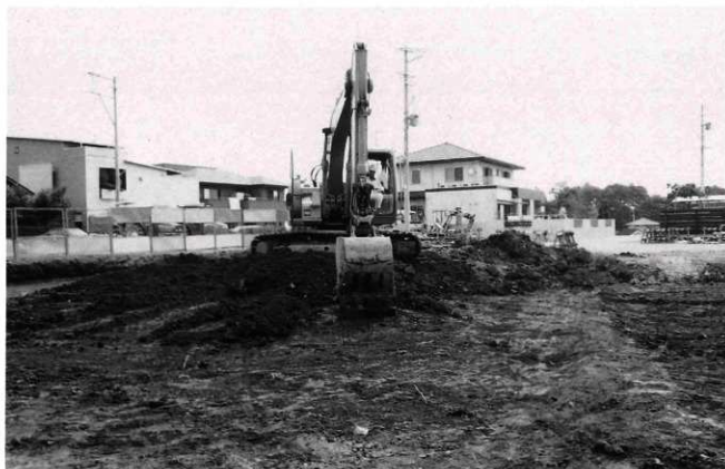
(2) 重機による表土掘削作業 (包含層が全域に及ばないため、遺構確認面まで表土を除去した。)
