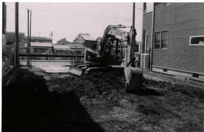
(2) 重機による表土掘削作業 (包含層がほとんど存在していないため、遺構確認面まで表土を除去した。)
