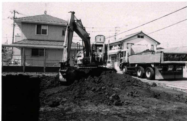
(2) 重機による表土掘削作業
