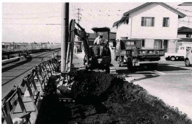
(2) 重機による表土掘削作業
