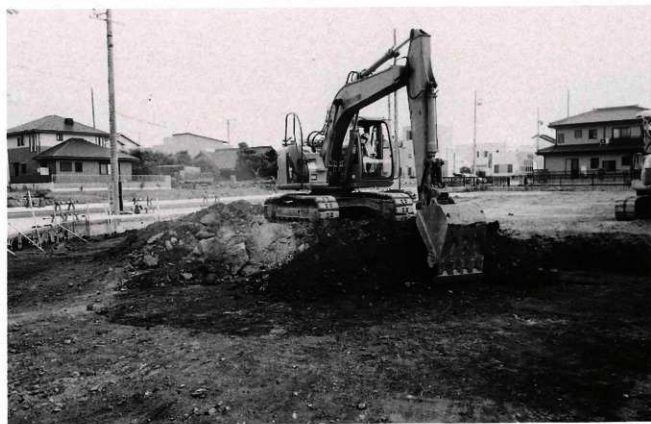
(2) 重機による表土掘削作業
