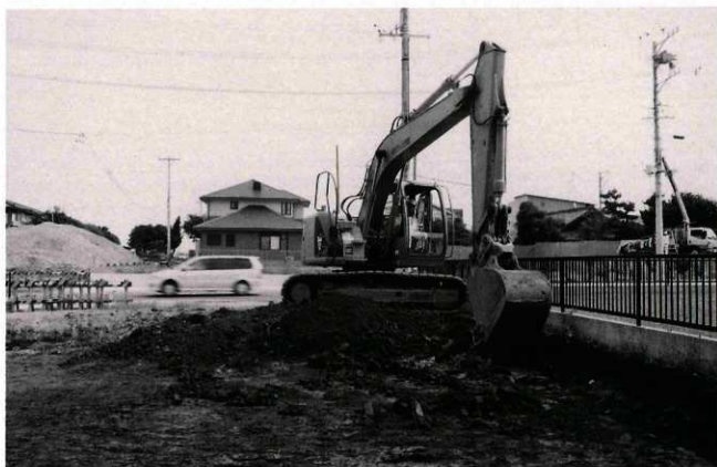
(2) 重機による表土掘削作業（包含層面まで表土を除去した。）
