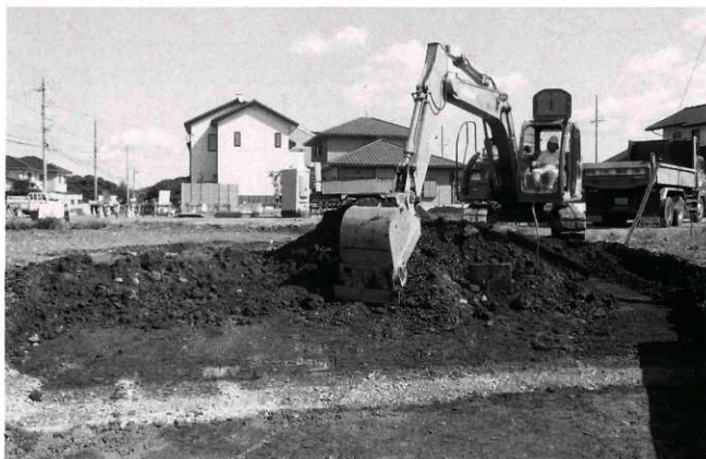
(2) 重機による表土掘削作業 (1調査区は攪乱により包含層がほとんど存在していないため、遺構確認面まで表土を除去した。)
