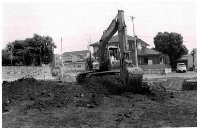
(1) 重機による表土掘削作業（包含層がほとんど存在していないため、遺構確認面まで表土を除去した。）
