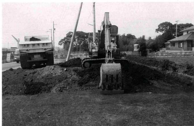
(2) 重機による表土掘削作業 (2調査区での作業である。)
