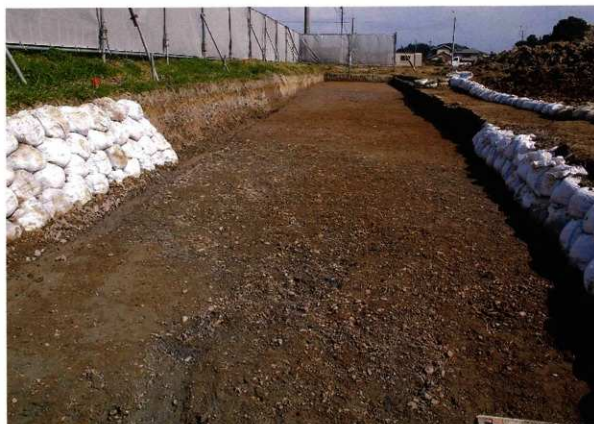
2 : 東工区／調査区西側（西から）
