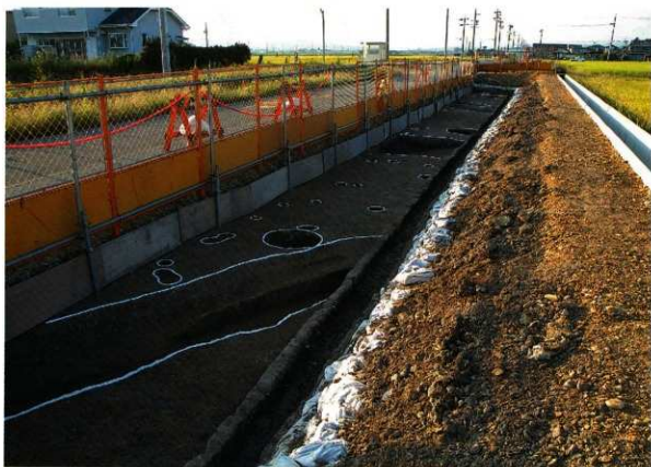
2：平成18年度 第2工区／調査区北半（南から）
