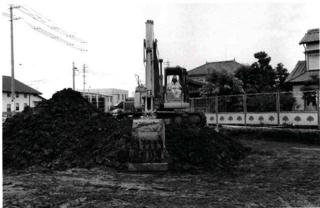
(1) 重機による表土掘削作業 (北西端で一部包含層が確認できたが、概ね表土を遺構確認面まで掘削することができた。)
