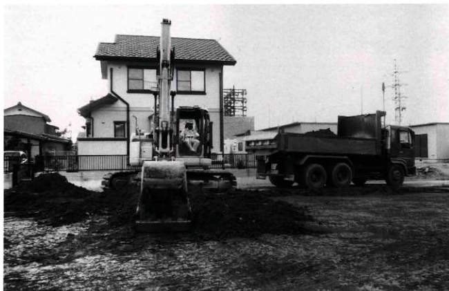
(1) 重機による表土掘削作業 (ほとんど包含層が存在していなかったため、遺構確認面まで掘下げることができた。)
