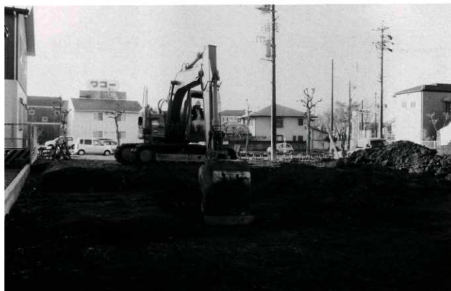
(2) 重機による表土掘削作業風景
