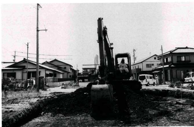
(2) 重機による表土掘削作業風景 (一部包含層が存在していたが、概ね遺構確認面まで表土掘削をすることができた。)
