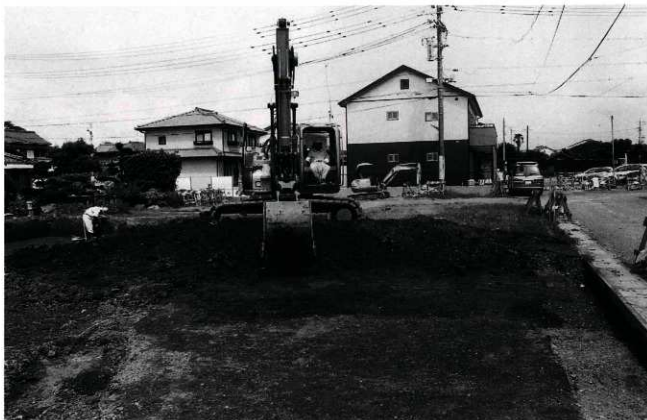
(1) 重機による表土掘削作業風景（一部包含層が存在したため、表土を掘削した。）
