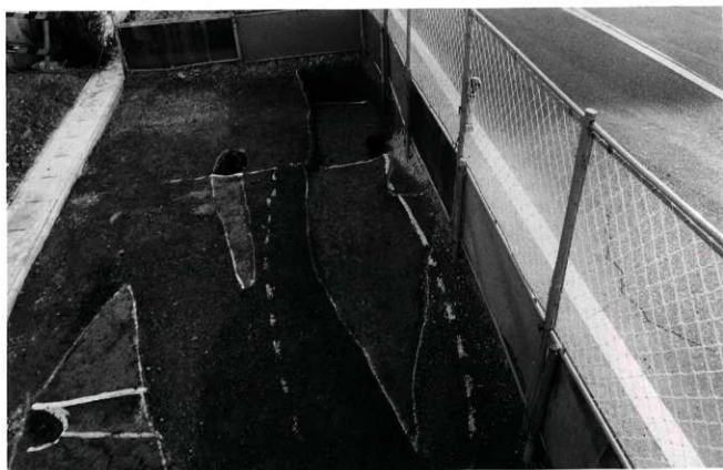
(2) SZ1東溝 (埋設物のためほとんど破壊されている。西より)
