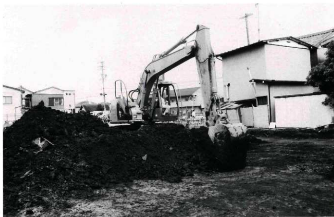
(2) 重機による表土掘削作業風景 (包含層がほとんど存在していなかったため、表土を遺構確認面まで掘削することができた。)
