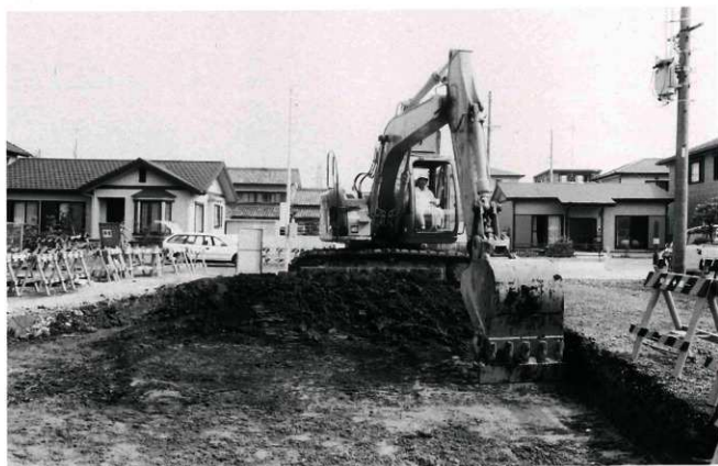
(2) 重機による表土掘削作業風景 (包含層が存在していなかったため、表土を遺構確認面まで掘削することができた。)
