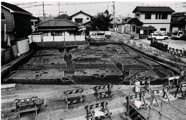
(2) 第39・40次東半発掘調査区全景 (遺構の保存状況は良好であり多数の遺構が見られた。東より)
