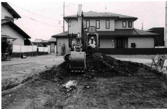
(1) 重機による表土掘削作業風景 (包含層が存在していなかったため、遺構確認面まで表土を掘削することができた。)
