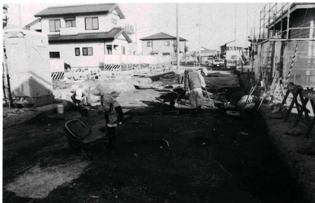
(1) 人力による作業風景
