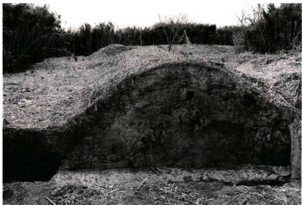
2.大岡堤土層断面1
