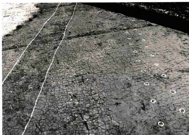
2. 北野灘跡内 浅羽大岡堤基底部
