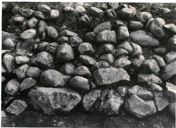
2 北側上段斜面 葺石基底石（北から）
