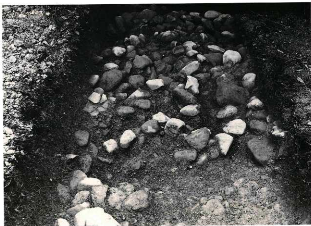
1 1トレンチ上段 崩落露石 (東から)
