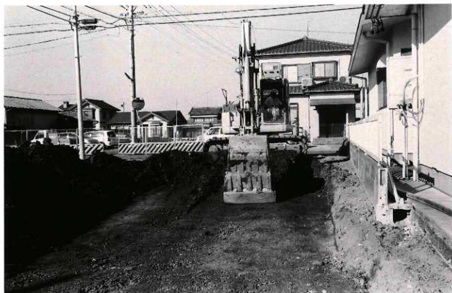
(1) 重機による表土掘削作業風景
