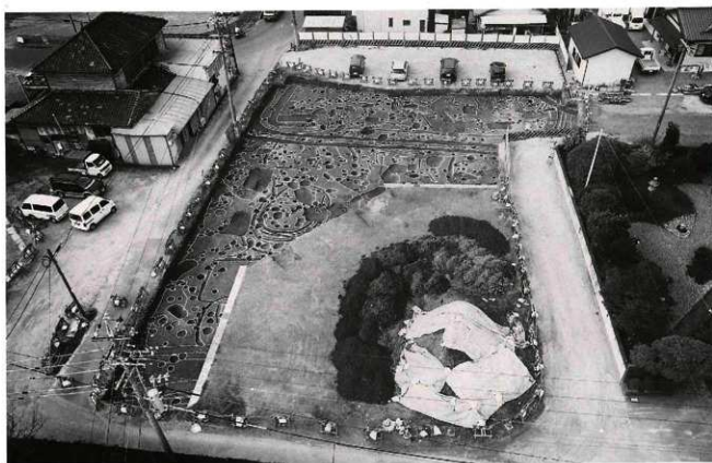
(2) 第33次発掘調査区空中写真全景 (弥生中・後期の竪穴住居や土坑、柱穴群が密集して見つかった。東より)
