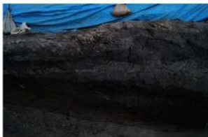
SR18 断面d-d'-3(北西より)
