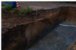
SR28 断面g-g'現道部(北西より)
