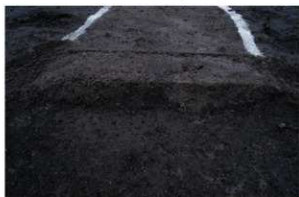
SD129 断面b-b'(南より)
