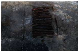
SR11-SX1 木質遺物接地面状況確認2(南より)
