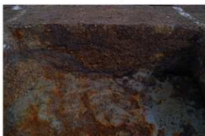
SD287 断面b-b'(南西より)
