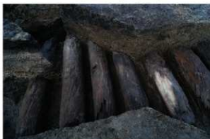
SR11 断面n-n'-7(東より)
