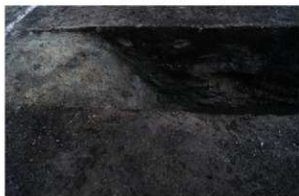
SR11 断面s-s'-2(南より)
