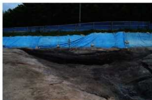
SR18 断面d-d'-1(北西より)
