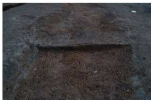
SD184 断面b-b' (南西より)
