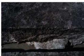
SR11 断面p-p'-2(南東より)
