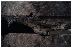
SR11 断面p-p'-1(南東より)
