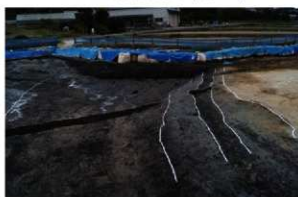
SR27 2面目検出状況3(北東より)
