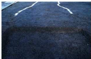
SD130 断面e-e'(南西より)
