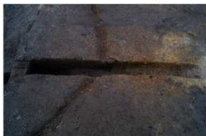
SR11-SX1 ⑭断面b-b'(南東より)
