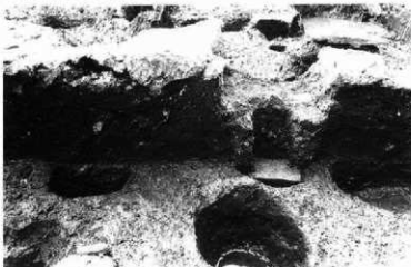
E. 建物1 柱穴5（写真右側）土層断面
