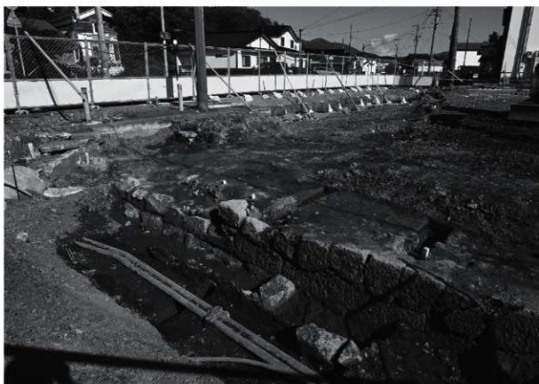
道道側調査前（石垣1西面検出） 南西から 調査前
