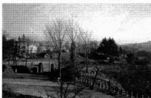
市民会館着工前 (昭和 37 年)
