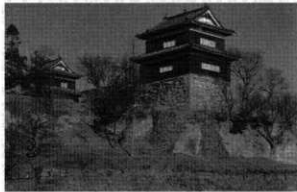
崩壊前の南櫓下の中段石垣 (昭和 42 年)
