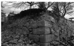
本丸西虎口石垣解体修復事業
