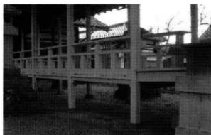
眞田神社社殿改修（平成22年）
