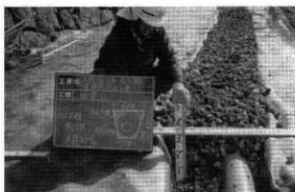
（西櫓南側）暗渠排水工
