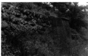
本丸堀の橋台撤去（昭和58年）
