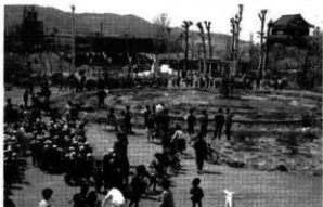
市民会館建設中 (昭和 37 年)
