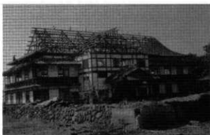
解体中の公会堂（昭和 37 年）
