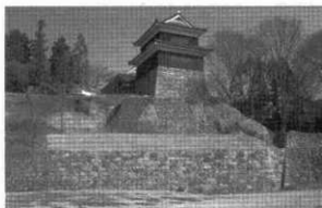
（南櫓下）石垣解体修復工事
