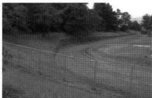
⑦ 百間堀の法面
