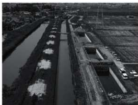
23B・C・E区全景(北から)
