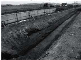
23E区旧河道(北から)
