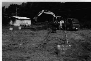
PL.35 H22,9,21 表土剥ぎと排土搬出
