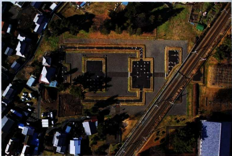
PL.18 H24 尼寺伽藍及び調査区全景 (真上 写真上が西)
