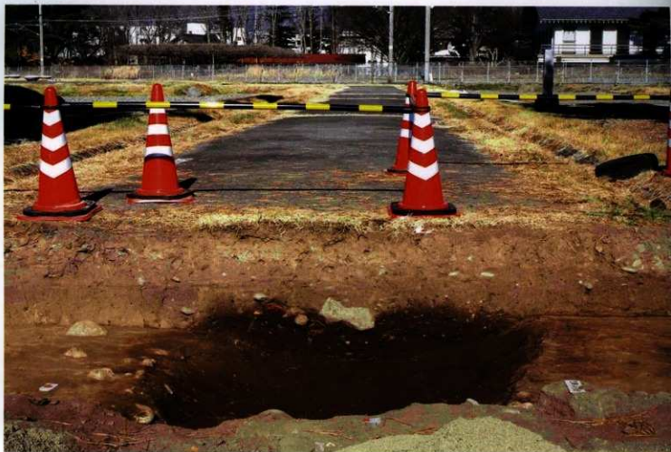
PL.22 H24 尼寺回廊南東隅調査区瓦集中区下溝跡セクション(南)
