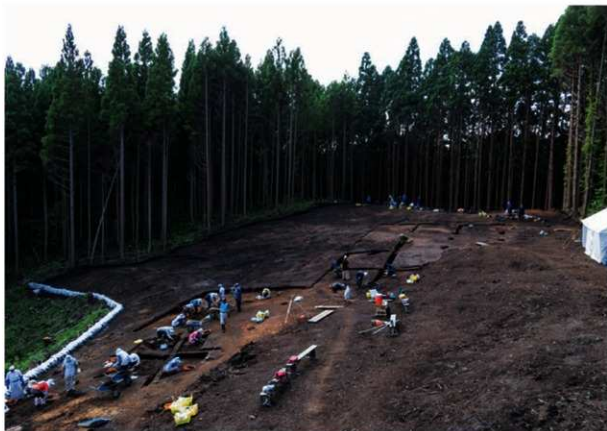
1 調査状況 (H27 年、東から)
