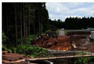
6 調査状況 (H28 年、西から)
