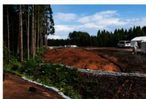
8 調査終了 (H28 年、西から)
