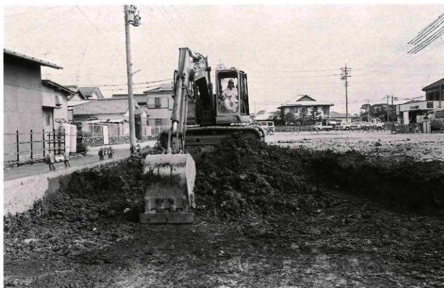
(1) 重機による表土掘削作業風景
