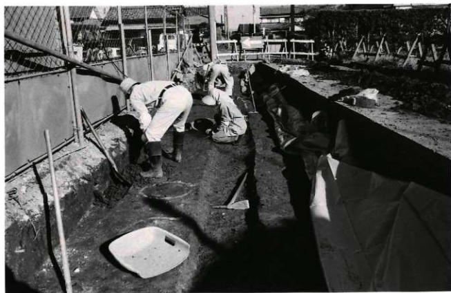
(2) 人力による作業風景
