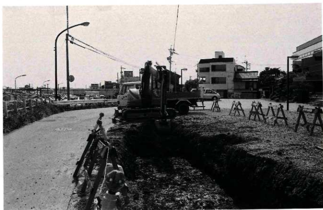
(2) 重機による表土掘削風景
