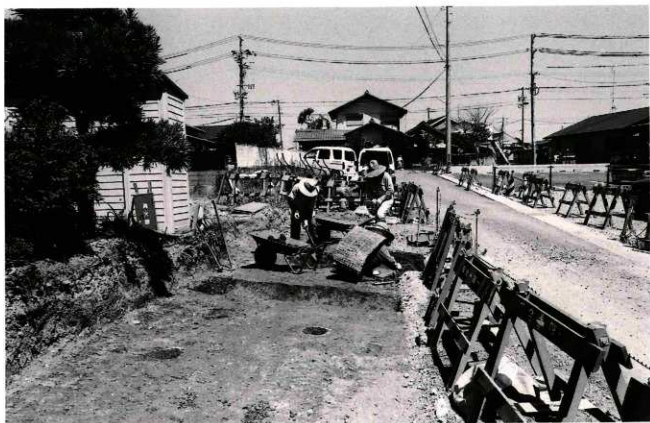
(1) 人力による作業風景
