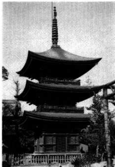
信濃国分寺三重塔（重要文化財）
