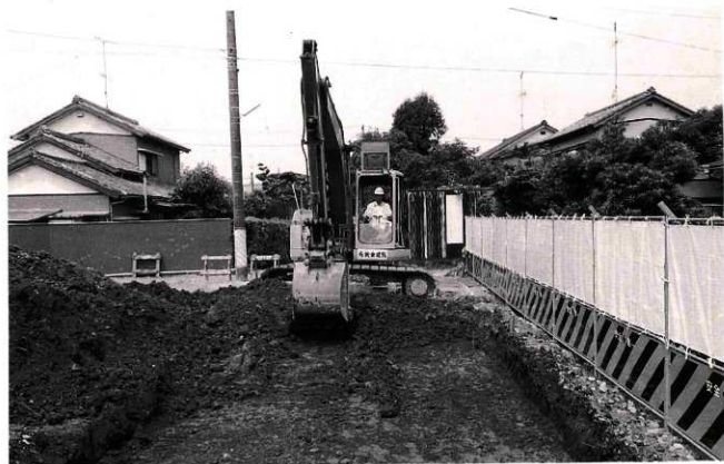
(2) 重機による表土掘削作業風景
