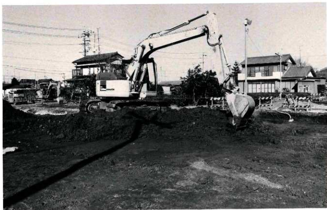
(2) 重機による表土掘削作業。(南区での作業。)
