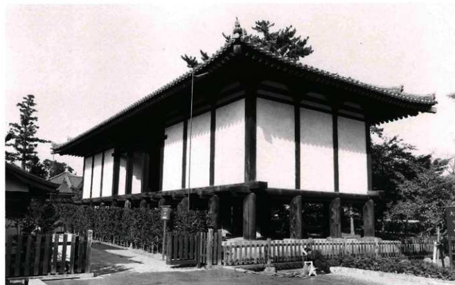
(2) 法隆寺綱封蔵（中央部分に壁がない。南より）
