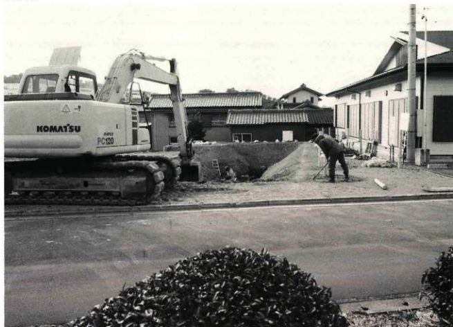
(1) 第4区の発掘調査の状況（東より）
