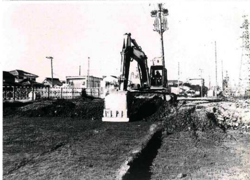
(3) 重機による表土掘削 作業風景
