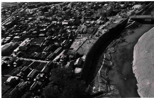
(1) 空中写真遺跡遠景 (東より)
