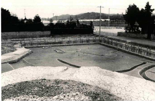
(1) 南地区東側完了写真(北西より)
