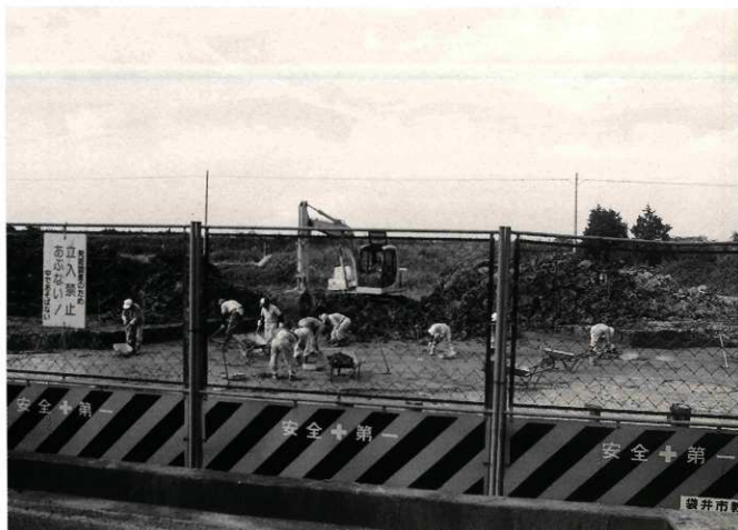
(1) 重機による表土除去作業
