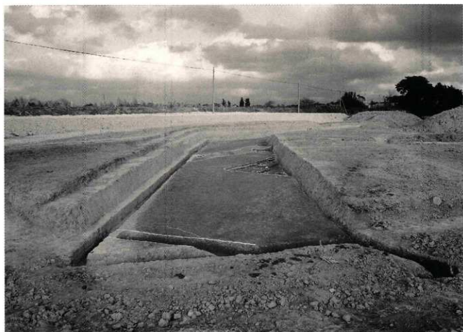
(2) 北地区 完了写真(西より)
