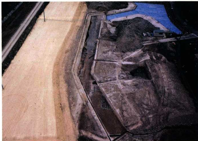
(1) 北地区完了写真。(西より)
