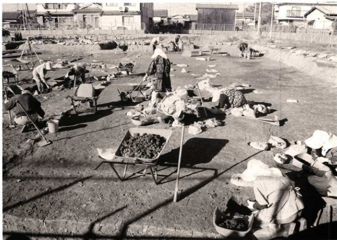
(1) 掘立柱建物跡 (SB 3) の調査状況
