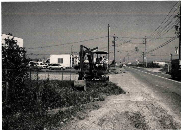
(1) 第5トレンチの掘削状況
