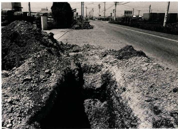
(2) 第3トレンチより北を望む。
