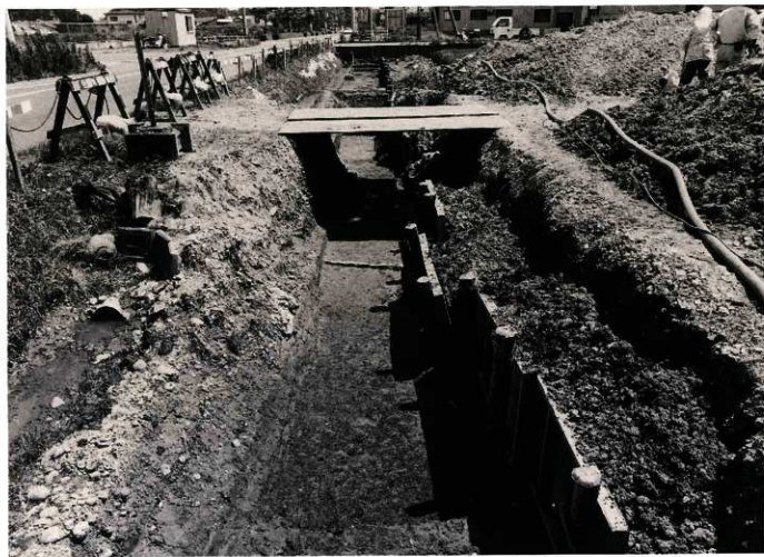
(2) 第2トレンチ (北側) 完了写真
